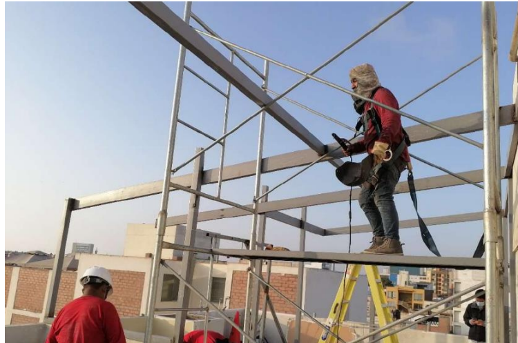
Figura 6. Personal realizando una instalación de estructura para un techo aligerado.
