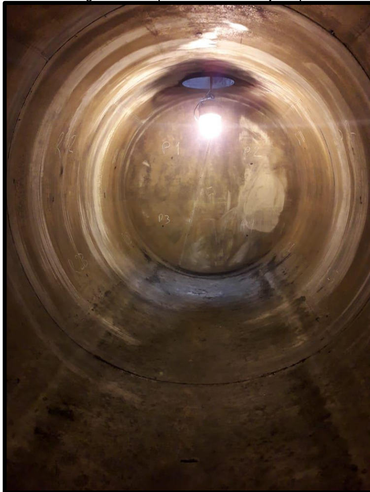
Figura 8. Interior del Tanque
