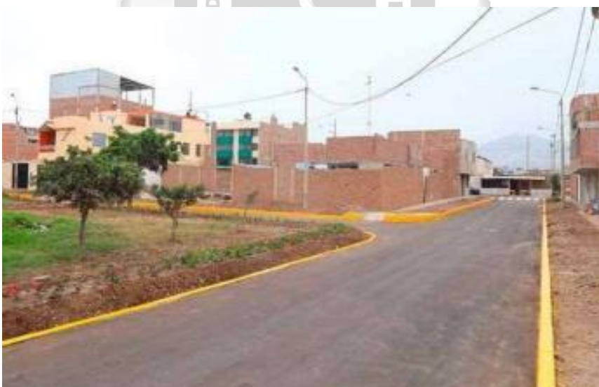
Figura N° 04: Obra en Ejecución
