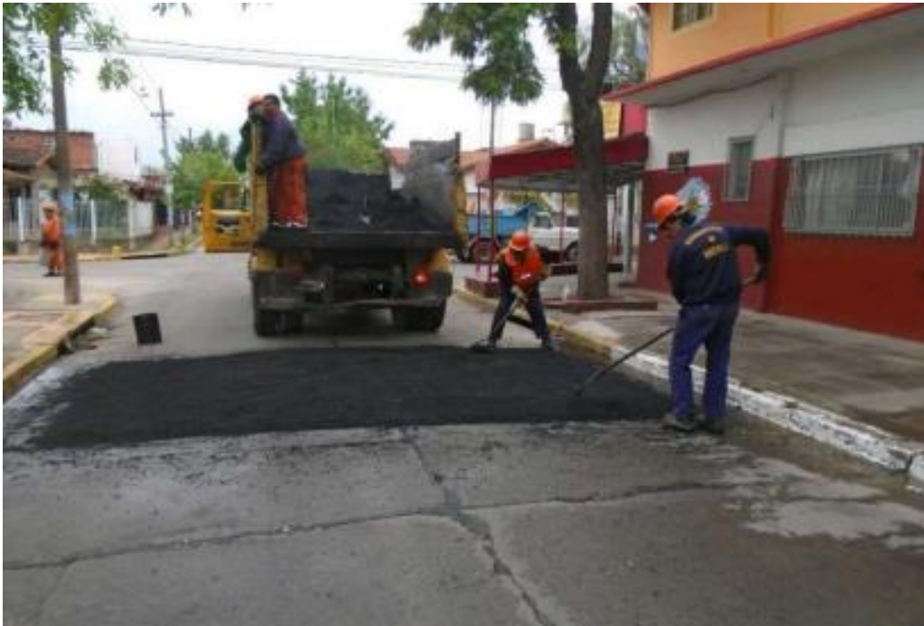
Figura N° 05: Obra en Ejecución
