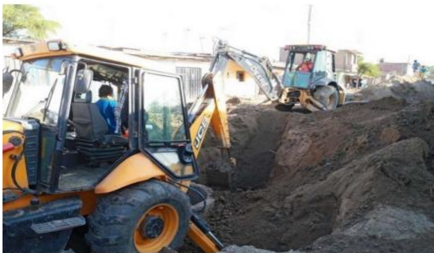
Figura N° 03: Obra en Ejecución
