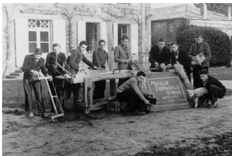
Figura 1: Construcción de la Maison Familiale Rurale en Francia
