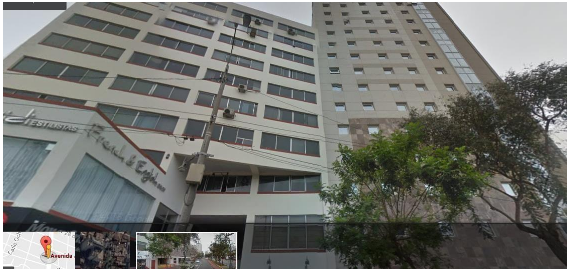
Imagen 1 Edificio Larco donde se encuentra ubicado Gestalperu SAC (Google maps)
