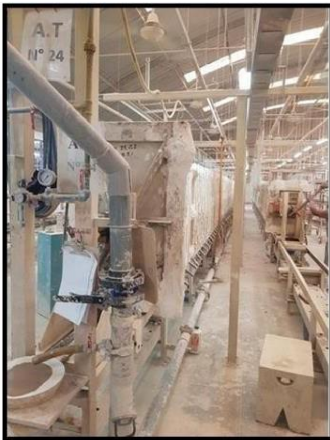
Figura 21. Representación gráfica de las líneas de moldes con los moldes ya instalados por los operarios.
