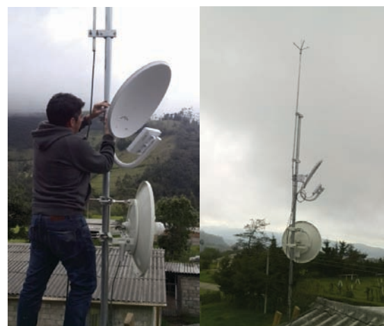
Figura 7: Instalación en casa del cabildo Puracé.
