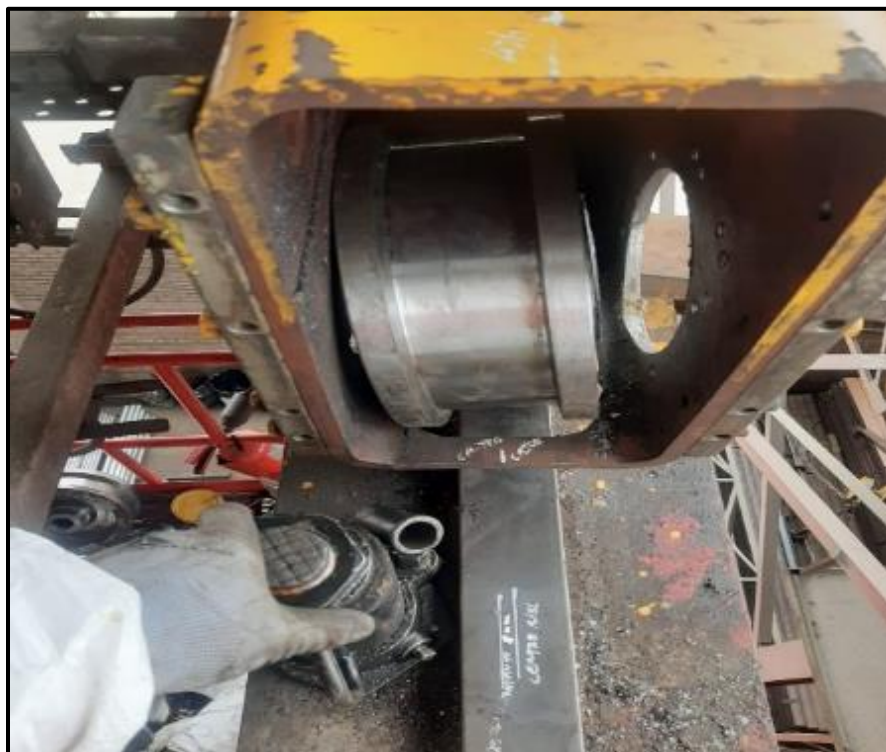
Figura 55: Montaje de nuevas ruedas testeras Fuente: Elaboración Propia
