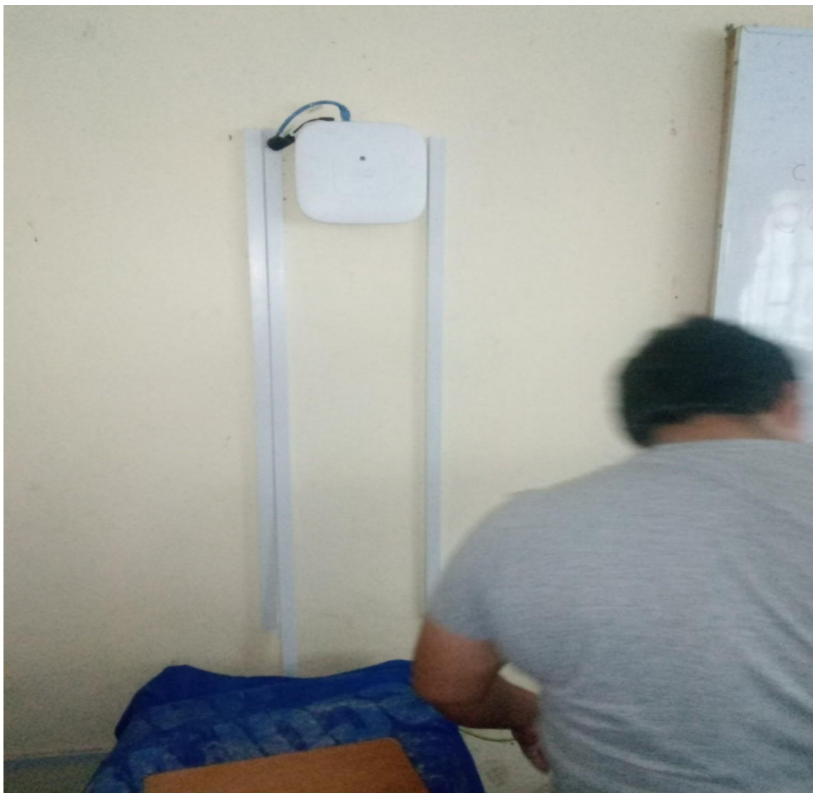
Colocación canaletas
