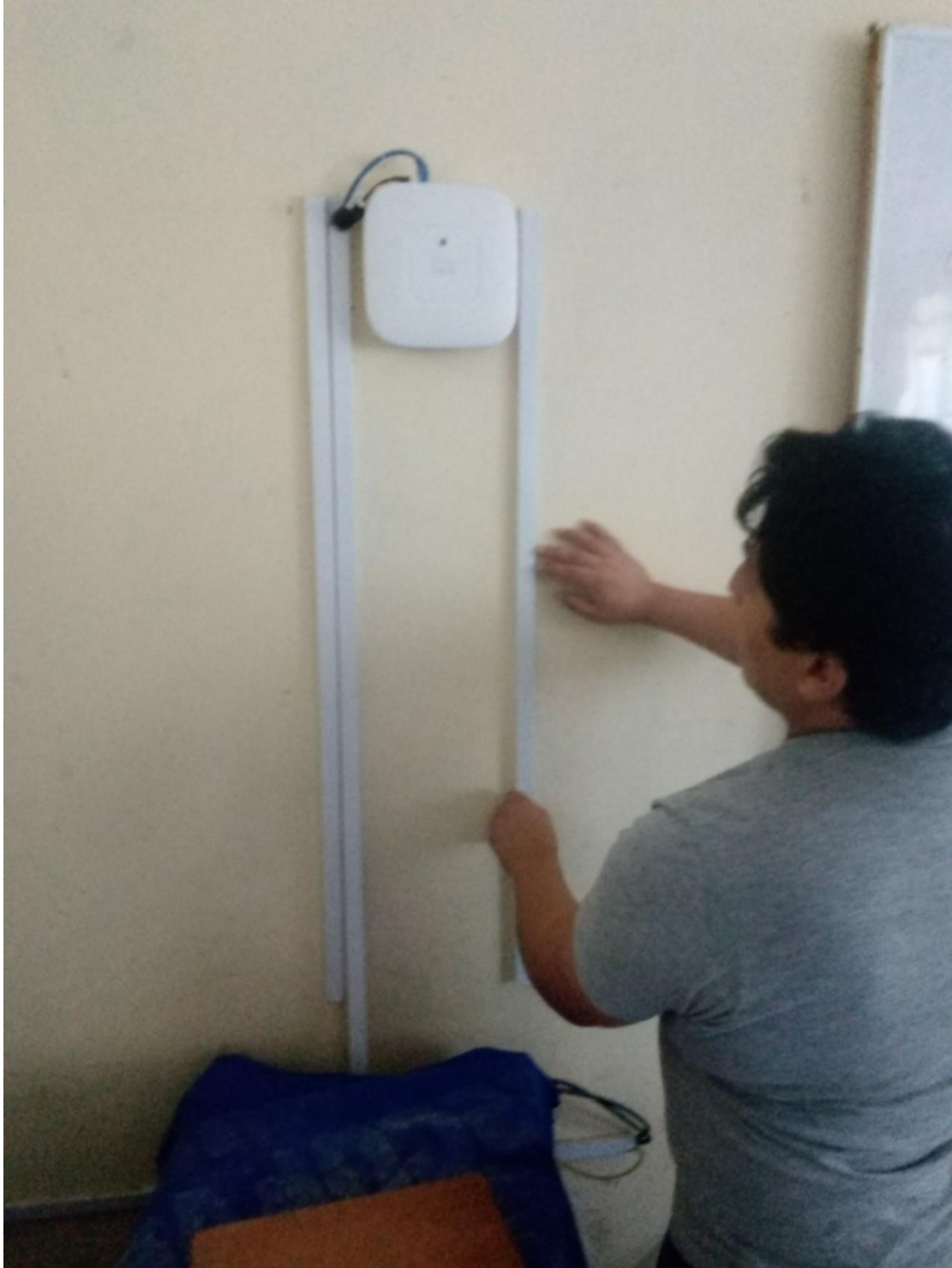
Colocación de canaletas.
