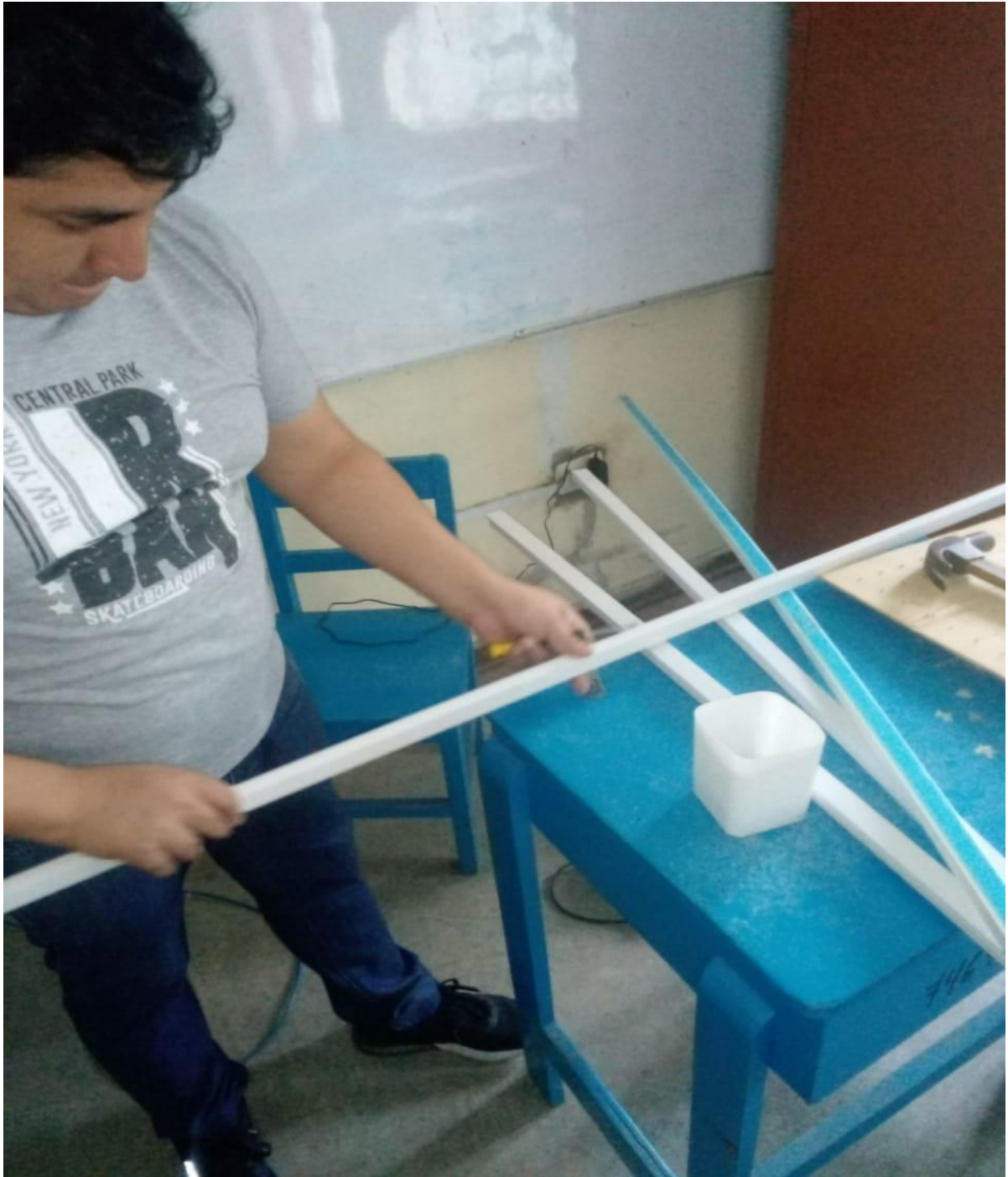
Colocación de las canaletas.
