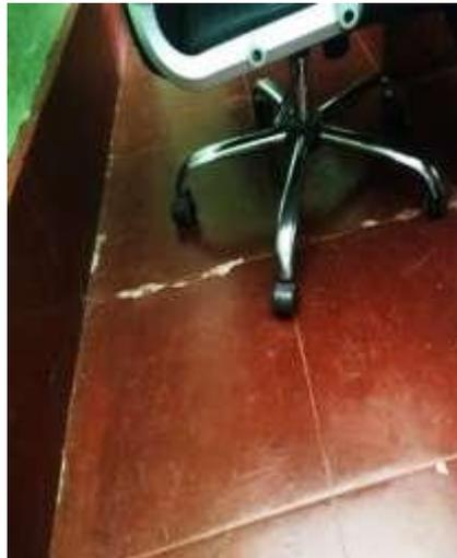
Figuras 56 y 57: Fisuras en los pisos.
