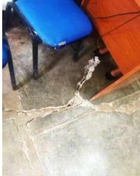
Figuras 25 y 26: Pisos y paredes gravemente afectadas con riesgo de desplomarse.
