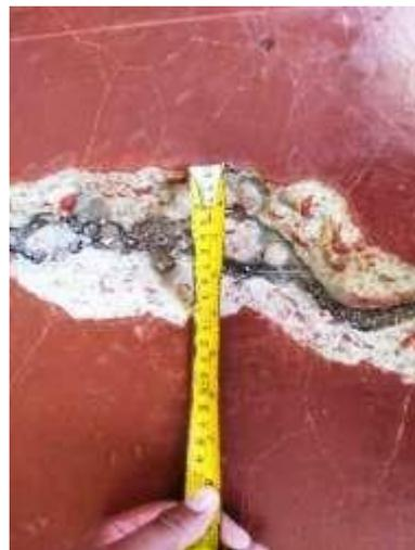
Figuras 68 y 69: Fisura de 10cmX400cm. Fisura de 2cm de altura.
