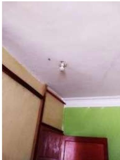
Figuras 84 y 85: Faltan luminarias e instalaciones eléctricas defectuosas.
