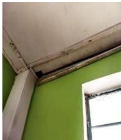
Figuras 106 y 107: Toma e interruptor malogrados. Pisos fisurado y techos con desprendimientos del cielo raso.
