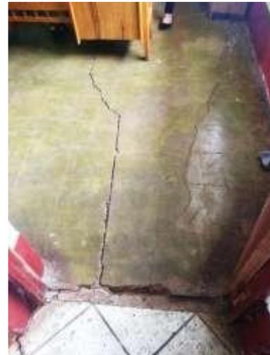
Figuras 62 y 63: Piso con fisuras. Fisura de 13cmX400cm.
