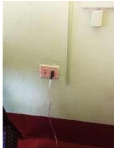
Figuras 104 y 105: Tomas e instalaciones eléctricas defectuosas e inapropiadas.
