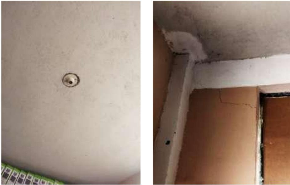
Figuras 99 y 100: Faltan luminarias y paredes con fisuras.
