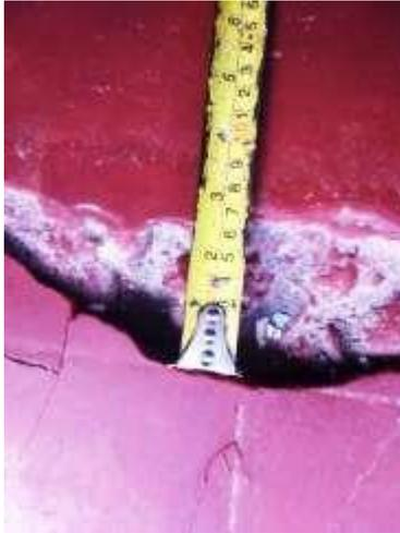
Figura 90: Piso fisurado.
