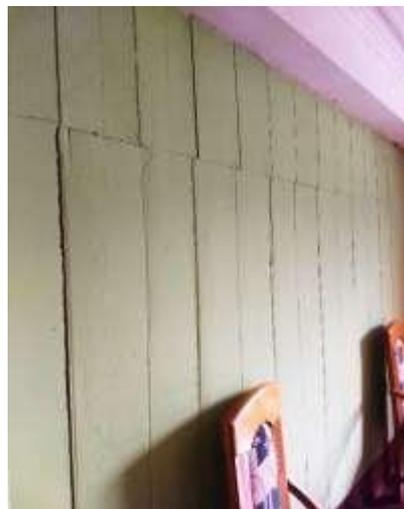
Figuras 88 y 89: Fisura de 1.5cmX250cm Fisura de 3cmX150cm. Paredes fisuradas.
