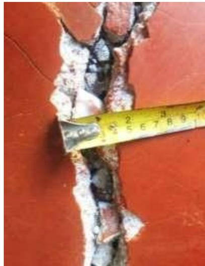
Figuras 40 Toma corriente suelto. Figura 41: Paredes fisuradas y a desnivel.
