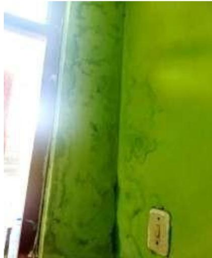
Figuras 44 y 45: Fisura de 1cmX250cm. Filtraciones de agua en paredes.
