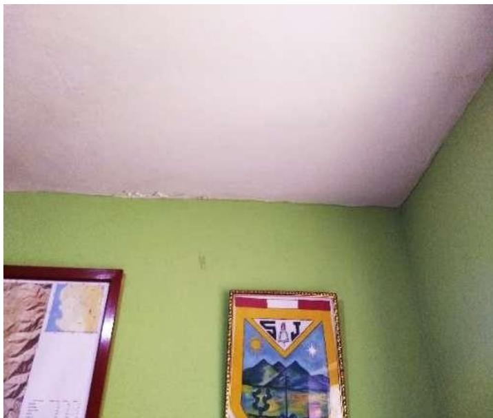
Figura 83: Requiere cambio de luminaria. Fisura en techo de 1cmX70cm
