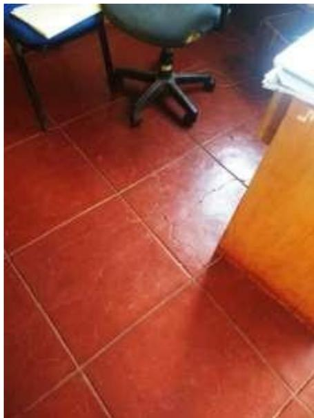
Figura 101: Piso con fisuras.
