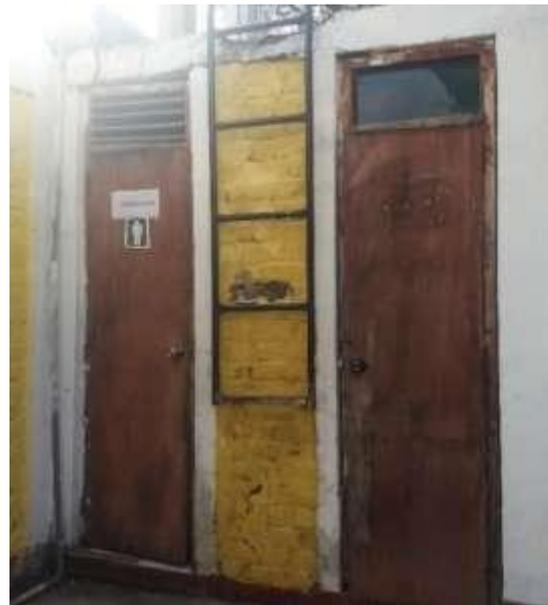
Figuras 52 y 53: Paredes y pisos parcialmente fisurados. Presenta humedad. Puertas totalmente deterioradas.
