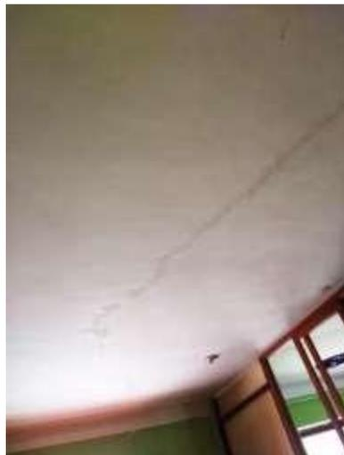
Figuras 86 y 87: Fisura de 2cmX400cm. Iluminaria malograda. Techo fisurado.
