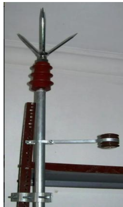
Figura 5.37 Pararrayos Tetra puntal (Fuente; Marca, MAGNET-WELD)
